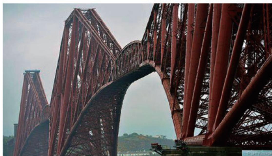
福斯铁路桥堪称工业时代的一大奇迹。该桥极具创意，主体由三个巨大的笼状悬臂组成，其花岗岩桥基位于福斯湾水下 46 米深处。大桥于 1882 年动工开建，于 1890 年竣工，成为英国当时第一座大钢铁桥。
