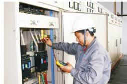
管老车间原由4条生产线，因为设计缺陷，无论是满负荷生产，冷却水泵都是满负荷运行。这在水泵的运行中存在“大马拉小车”现象，浪费严重。他根据环管道生产的优点，在电气控制上做改造，根据车间生产情况将冷却水泵无法停机特点，采用了变频器与PLC可编程控制器相结合的方案，既不影响正常生产，而且又能达到节能增效的目的。仅此项，高压管车间一年可以节省电费20多万元。
